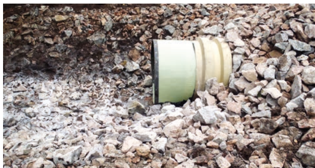
FODRET SVÄLLER UPP VID TRUMÄNDEN OCH FUNGERAR SOM ETT DRAGSTAG, VILKET GÖR HELA BANVALLEN MER STABIL.
