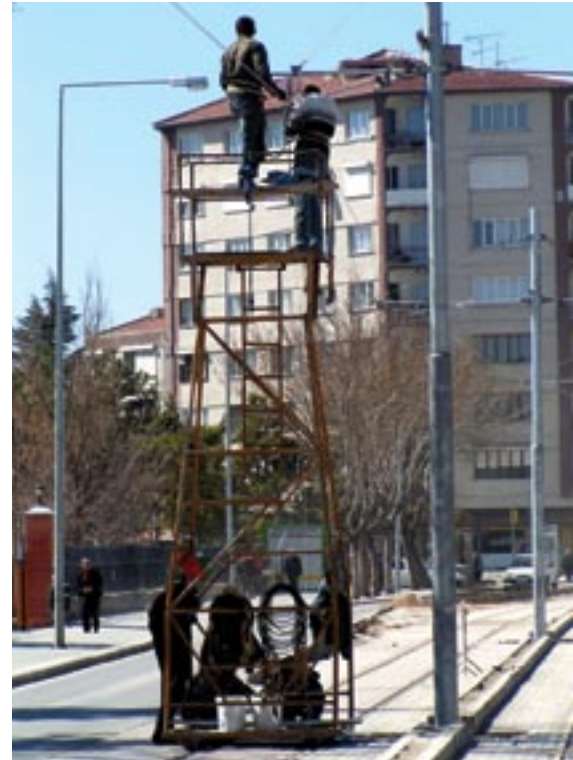
”Rullande älgtror” kallar Stig Tranborg de fordon man använde för att montera kontaktledningarna. Två monterare och en skjuter på.
