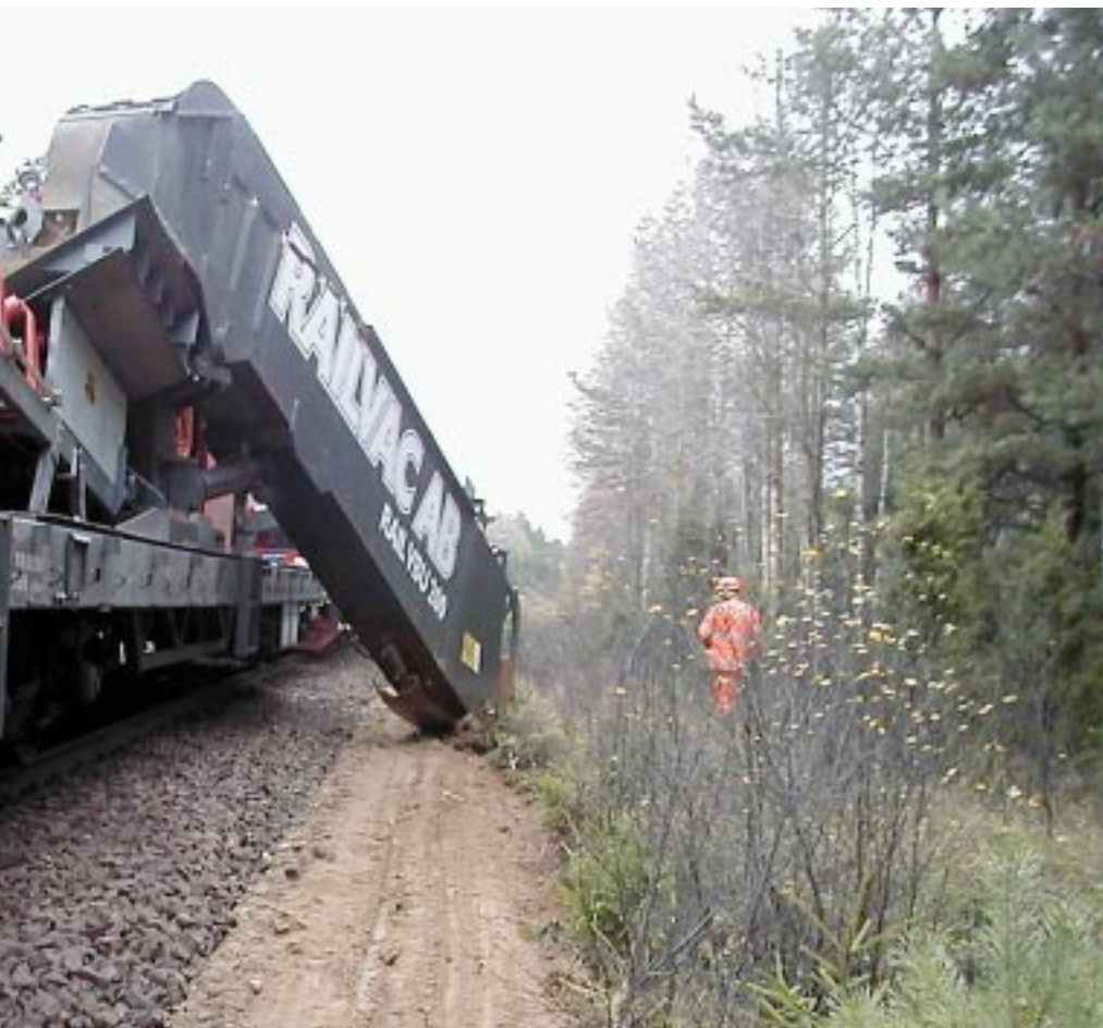
lastvagnarna på VBU 200. Maskinen tar i varje vända 80 cm på ömse sidor om spåret. svep.
