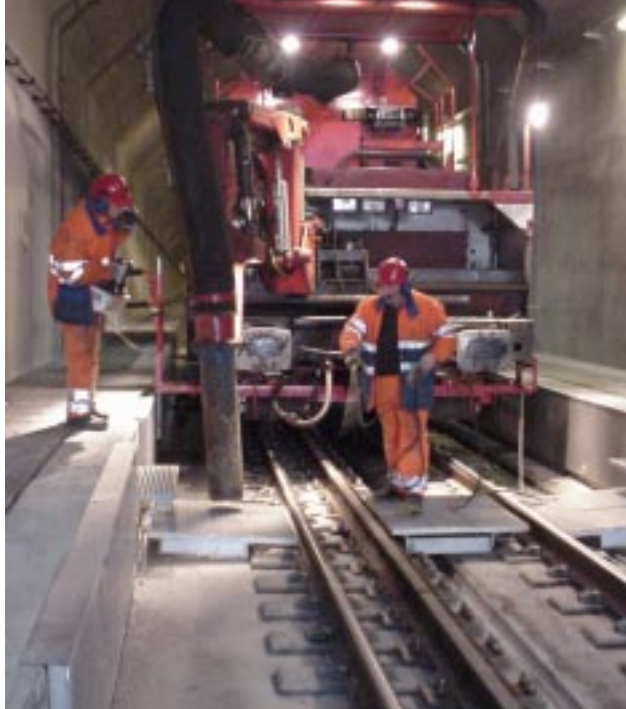
Nytt årtusende - ny bro - ny tunnel - och nytt jobb för Railvac.
